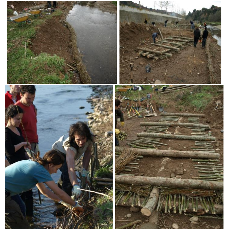
Imágenes de la fase de construcción
