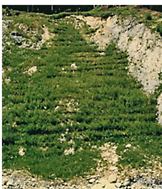
Estabilización de un deslizamiento en los Alpes austríacos- Foto F.Florineth
